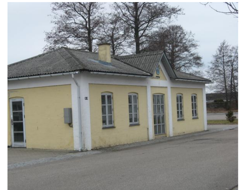
Vaskehus for røgsvagt krudt, 1906.
