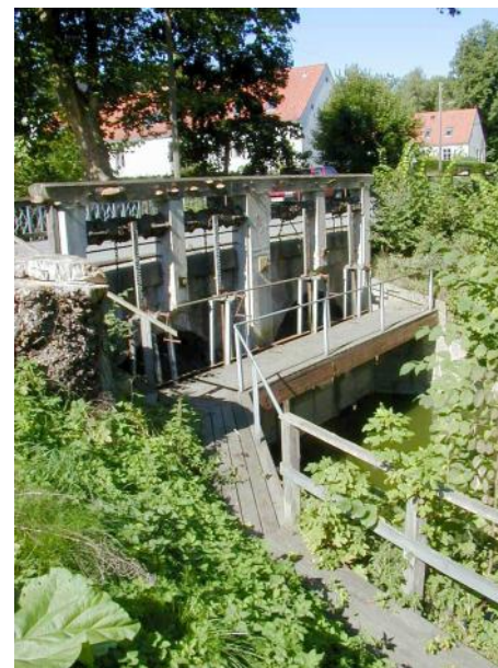
Det imponerende stemmeværk ved Kanalens øverste fjerdedel (5.5).
